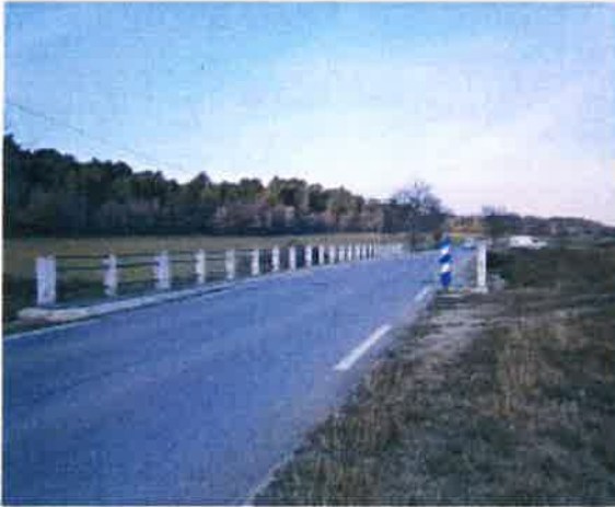
Le pont de la RD 37 : vue vers le nord-est
