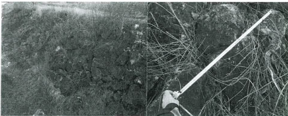
Vue (ensemble et détail) sur l'encrochement en place au niveau de la digue en rive gauche
