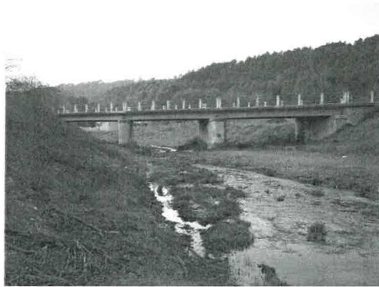
Vue amont du pont de la RD37
