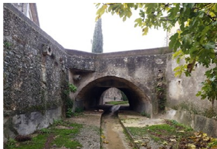
Lit bétonné dans la traversée de la Bastide-des-Jourdans (BASJ_3 – L'Eze)
