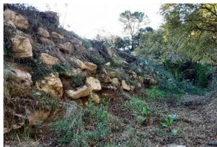
Enrochement en rive gauche du vallon du Rivet à Mirabeau (MIRA_4)
