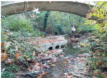
Ancienne section busée en état de ruine sur l'Aigue Brun (PUYV_6)
