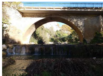
Seuil d'un radier d'ouvrage sur l'Eze à la Tour-d'Aigues (TOUR_5)
